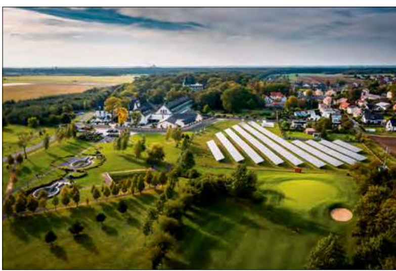
Instalacja fotowoltaiczna ma łączną moc 943,68 kWp.
