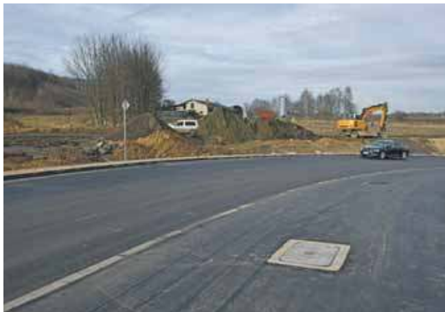
Prace wciąż są prowadzone, wszystko ma być gotowe do końca marca 2025 r.
