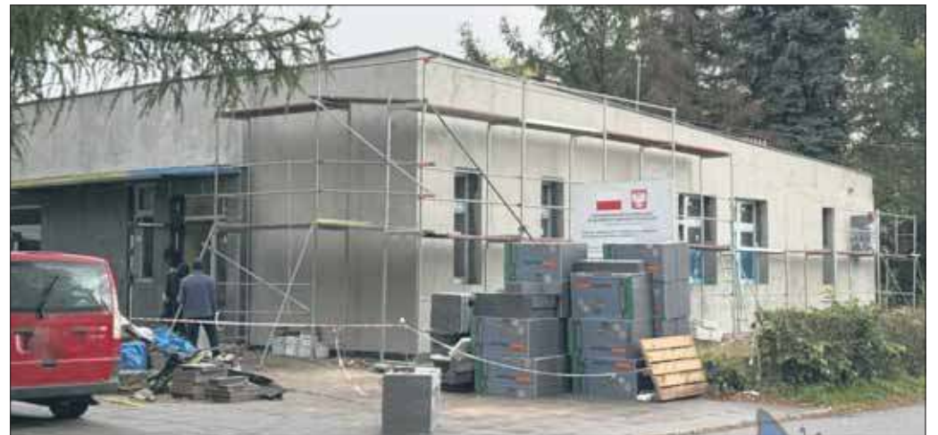
Remont przychodni ZLO Łubowiec
