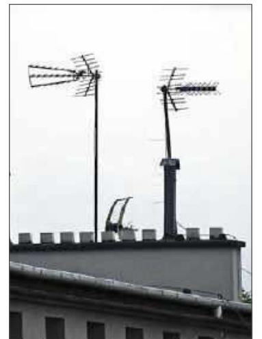
Anteny pozostaną te same.
