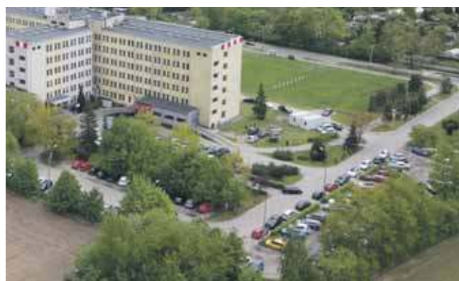
Parking przy Wielospecjalistycznym Szpitalu Powiatowym w Tarnowskich Górach jest za mały, a jego nawierzchnia w złym stanie
