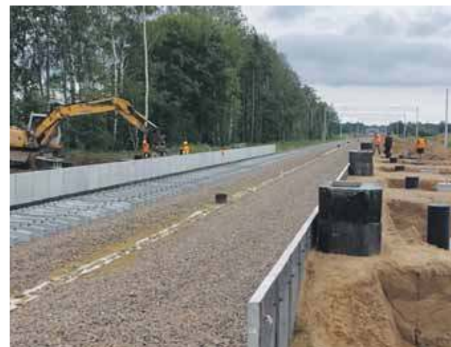
Postępuje budowa kolei do lotniska w Pyrzowicach
