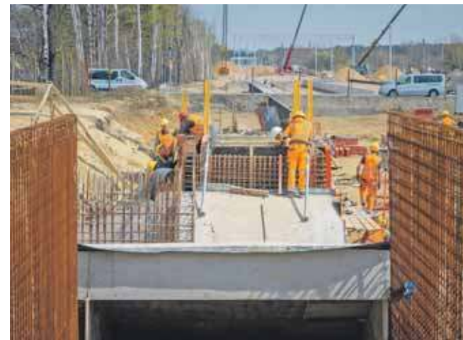
Widać już perony i przejście podziemne
