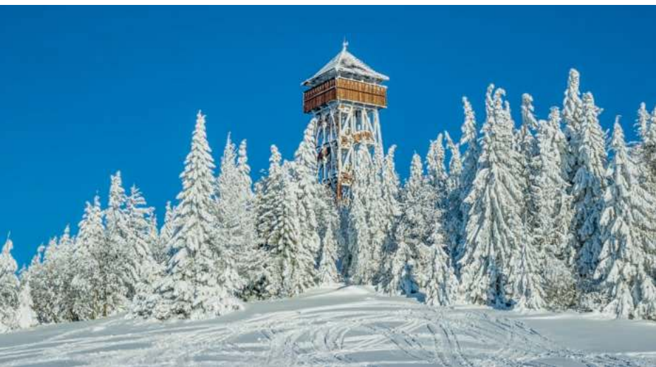
Wieża widokowa na Lubaniu, Gorce, styczeń 2017 r.
