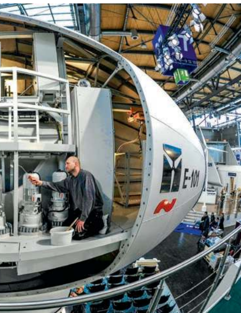
Malowanie wnętrza turbiny wiatrowej przed targami technologicznymi w Hanowerze, kwiecień 2011 r.
