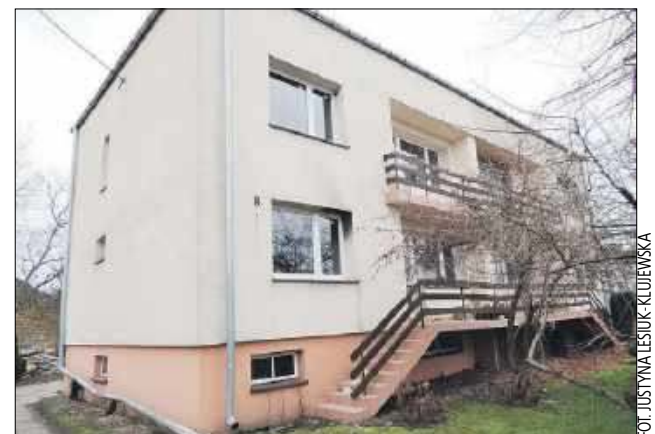
Dom Barbary Prudaczuk powoli odzyskuje dawny wygląd. Wszystko dzięki ludziom dobrej woli. Po pożarze dom był częściowo zniszczony. Trwa zbiórka na remont
