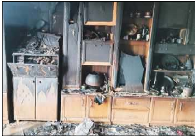
Tak wygląda wnętrze domu po ugaszeniu pożaru
