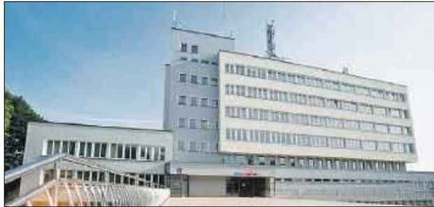
Wyłoniony już został wykonawca modernizacji budynku. To firma z Białej Podlaskiej
