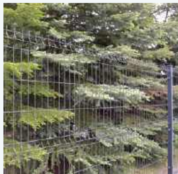
➤ Zastosowano panele wykonane z grubszego drutu (5 mm), ocynkowane, z powłoką lakieru proszkowego (antracyt).
