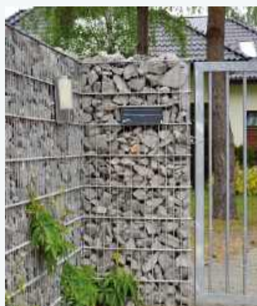
📍 Główna furtka (szerokości 1,1 m) z wideodomofonem i elektrozaczepem, przy niej skrzynka na listy.
