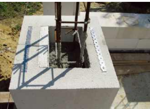
🔧 Kształtki U jako szalunek dla słupów. T. RYBARCZYK
