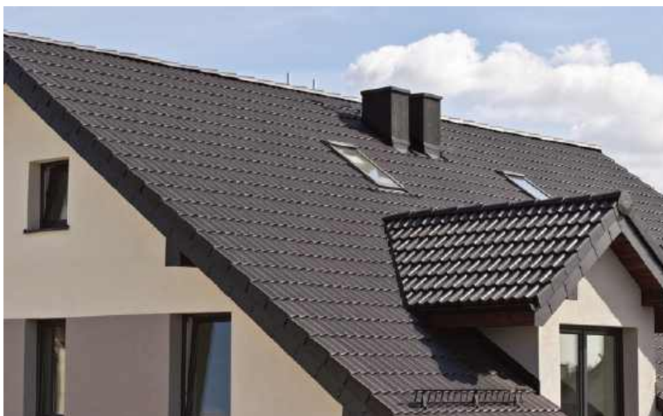
📌 Dachówki cementowe są odporne na porastanie mchem, mrozooodporne i mało nasiąkliwe. swissporTON
