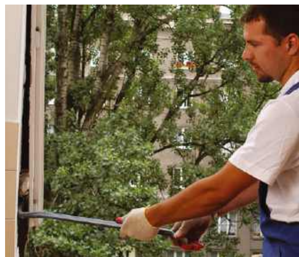
❷ Za robociznę przy wymianie okien zapłacimy więcej niż za montaż w nowym domu. OKNOPLAST
