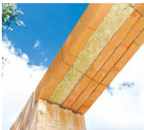
🔧 Ceramiczno-żelbetowa belka nadprożowa ocieplona wełną mineralną. wienerberger
