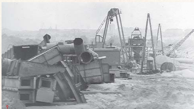
Pierwsze partie urządzeń na placu budowy
