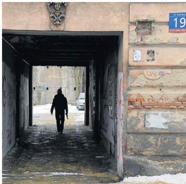
W kamienicy przy ul. Kaliskiej zamrzły dwie osoby
