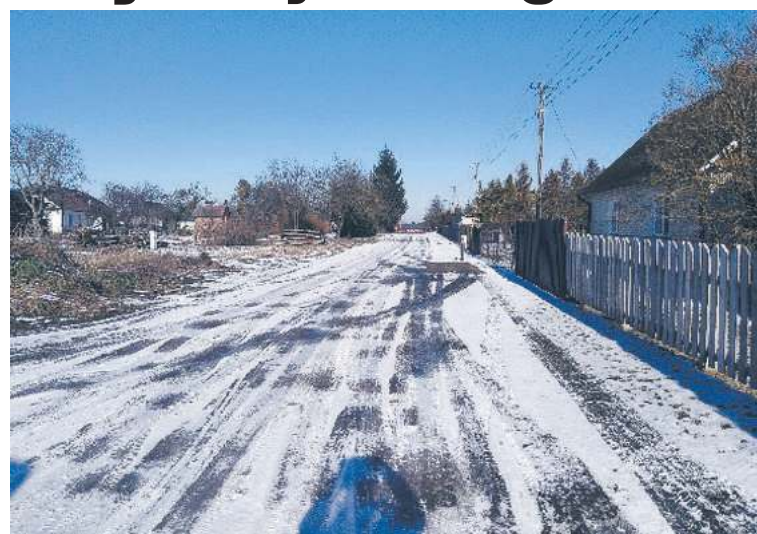
Droga w Krasówce wkrótce będzie przebudowana
