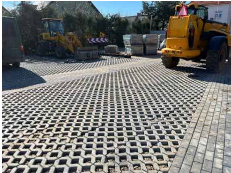
Na ulicy Ogrodowej, w pobliżu Gminnego Centrum Kultury trwa budowa targowiska gminnego
