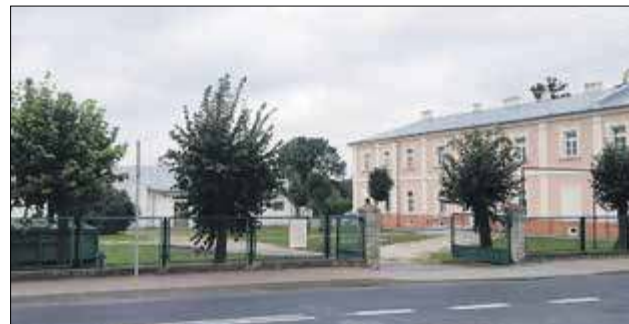
Konserwator nie zgadza się na budowę hali sportowej tuż przy zabytkowych budynkach dawnego klasztoru. Dyrektor tłumaczy, że to jedyne racjonalne rozwiązanie
