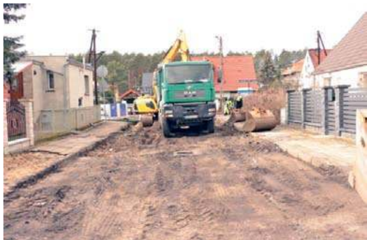
Prace remontowe nabierają coraz szybszego tempa
