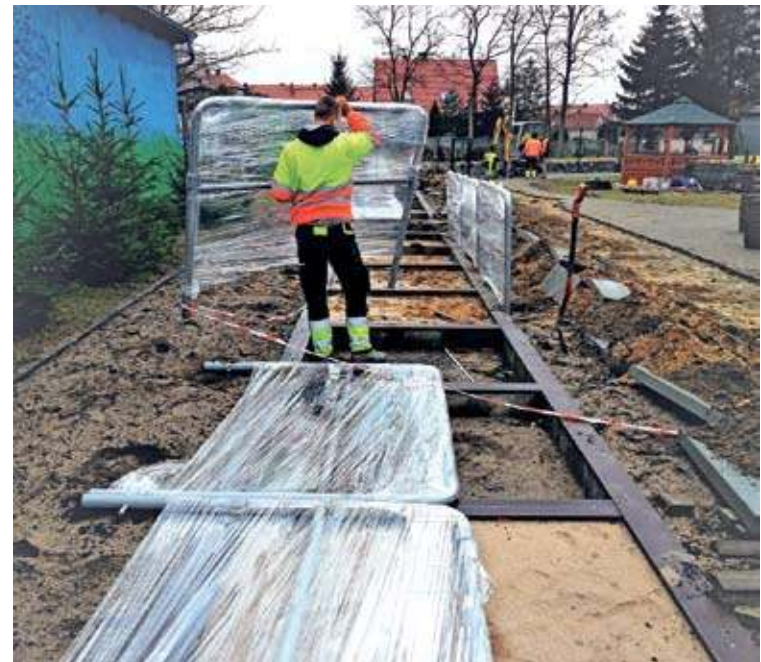
Prace na terenie CAS zbliżają się ku końcowi
