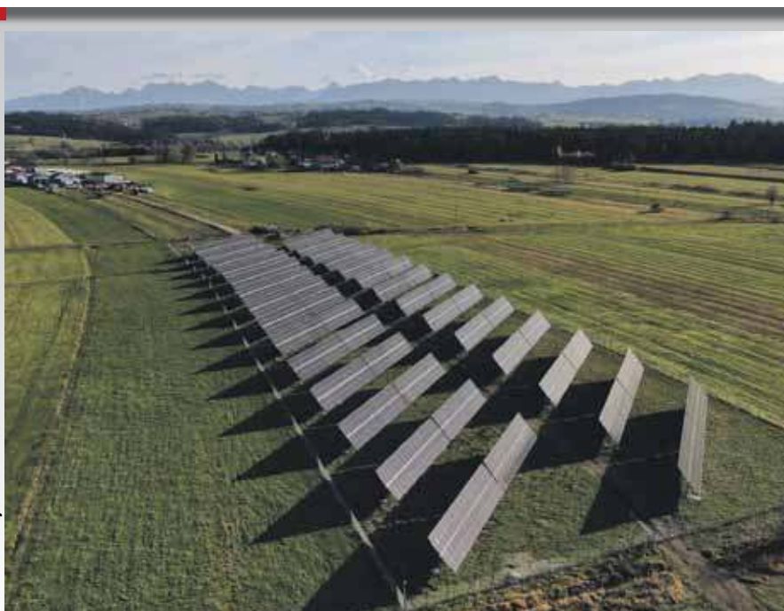
Czarny Dunajec. Ogromna instalacja fotowoltaiczna z widokiem na Tatry.
