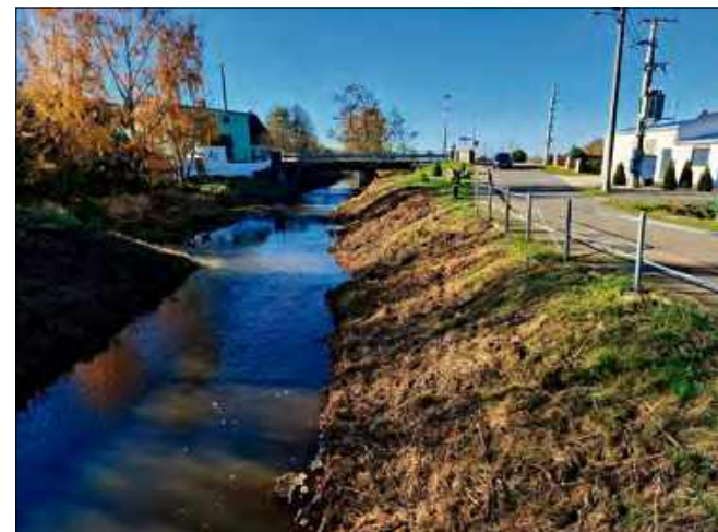
Koryto rzeki zostało oczyszczone.
