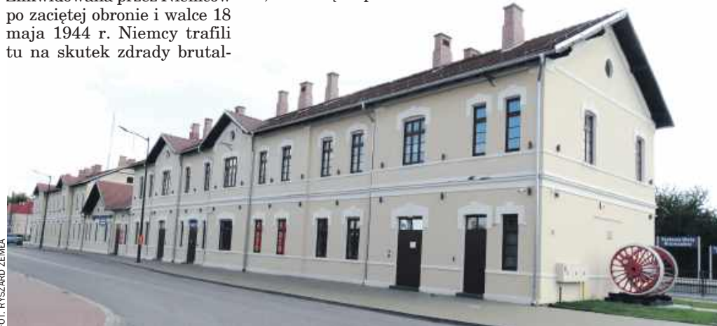
Rozwadowski dworzec kolejowy po remoncie
