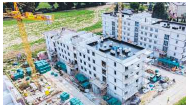
Na osiedlu Ogrodowym w pierwszym etapie powstaje trzy bloki mieszkalne
