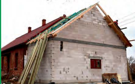
Remiza OSP i świetlica w Lubocieniu w trakcie przebudowy
