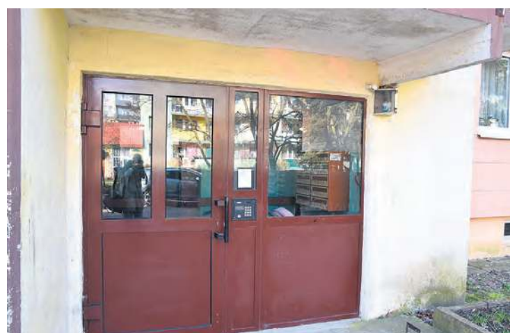
Podświetlane platfony z numeracją przy klatkach? Takie rozwiązanie chcą wdrożyć w spółdzielni. Póki co informacja z numerami mieszkań znajduje się przy domofonach.
