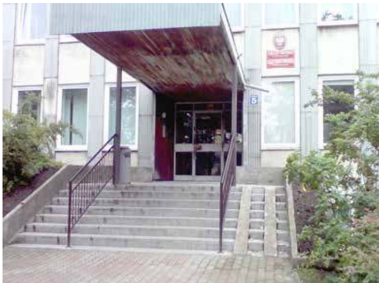
Obecnie z podjazdu do budynku przy Placu Wolności 5 nie są w stanie korzystać osoby na wózkach
