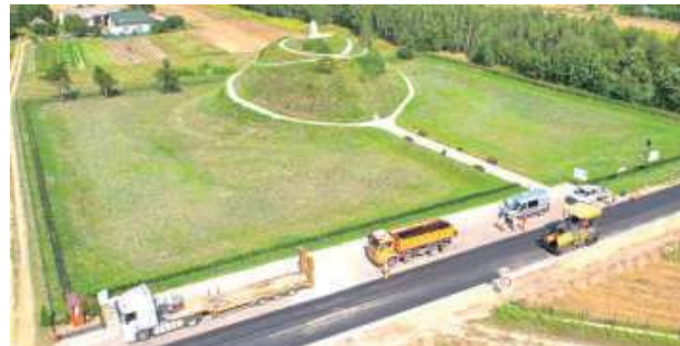
Przebudowa drogi powiatowej w miejscowości m.in. Okrzeja to kolejna inwestycja mająca na celu poprawę bezpieczeństwa i komfortu jazdy dla mieszkańców oraz osób odwiedzających Kopiec i Muzeum Henryka Sienkiewicza w Woli Okrzejskiej
