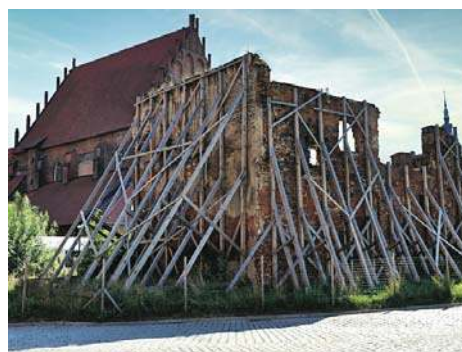
O krok bliżej do remontu Galerii EL | 3
