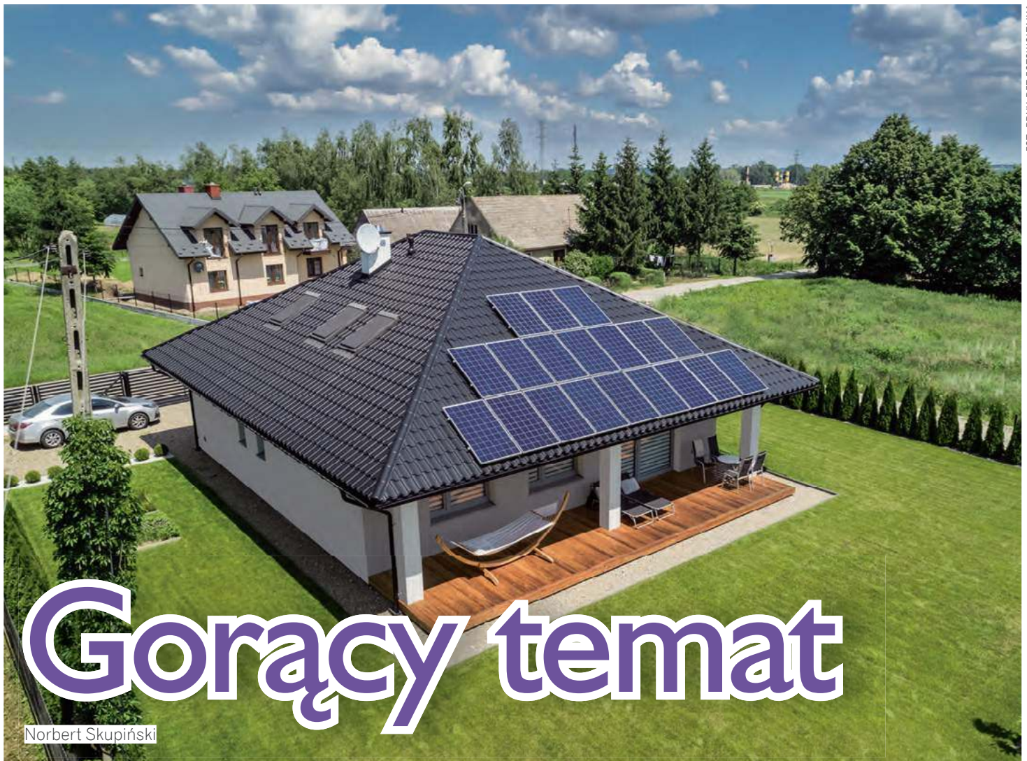
FOT. BRUK-BET FOTOWOLTAIKA
