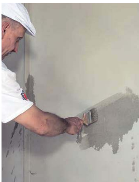
📌 Przed nałożeniem gładzi ścianę się gruntuje. BAUMIT
