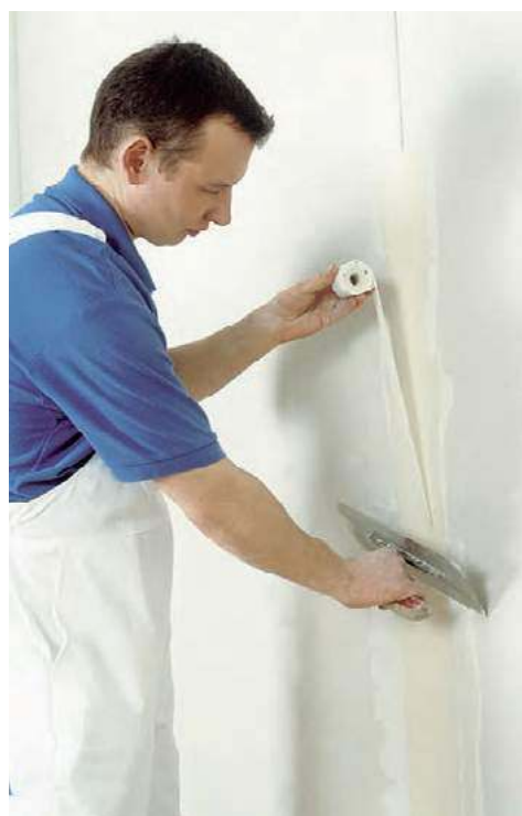
➋ Szpachlowanie połączeń płyt g-k z zastosowaniem taśmy zbrojącej. KNAUF we i cementowo-wapienne), płyty g-k, nawet pomalowane tapety tekstylne. Stosuje się je wyłącznie wewnątrz budynków. Trzeba pamiętać, że gips w połączeniu z wilgocią przyspiesza rdzewienie stali, dlatego elementy stalowe, które będą się z nim stykać, należy zabezpieczyć przed korozją.
