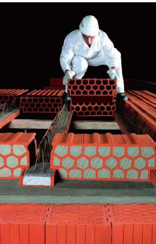
📌 Elementy nośne stropów gęstożebrowych to zbrojone belki, pustaki pomiędzy nimi są jedynie wypełnieniem. WIENERBERGER
