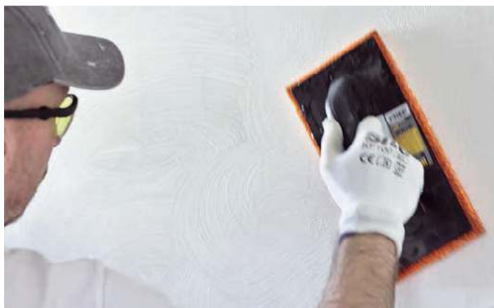
🔗 Gładź można też wykończyć na mokro – to tzw. gąbkowanie, pozwalające uniknąć szlifowania. DOMINIK DOMAŃSKI/FRANSPOŁ
