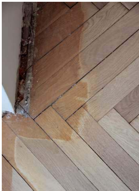
🔧 Cyklinowanie to najprostszy sposób odnowienia posadzki z litego drewna. J. WERNER
