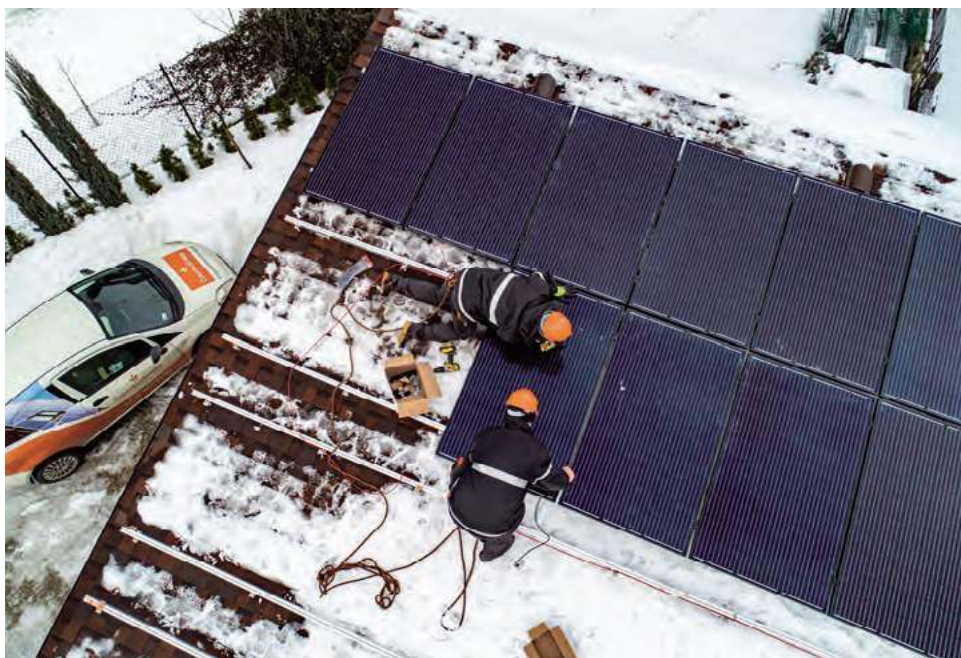
☛ W Polsce najczęściej spotykane są instalacje typu on-grid, w których nadwyżka energii oddawana jest do sieci. COLUMBUS ENERGY
