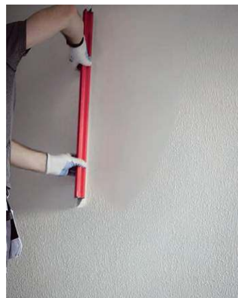
📌 Po nałożeniu gładzi wygładza się narzędziem nazywanym szpachlą.
