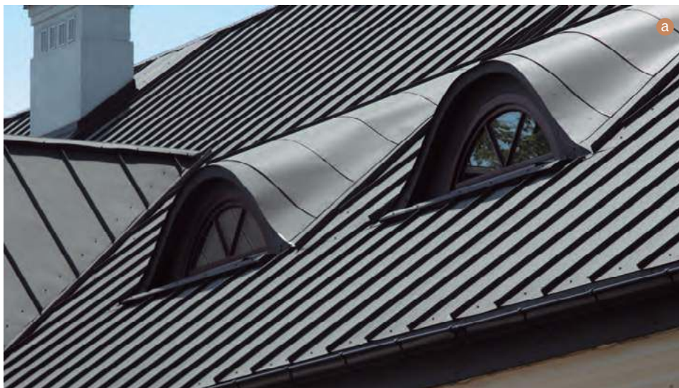
🔗 ➡ Blacha płaska łączona na rąbek (a RUUKKI) i jako gotowe panele karo (b BLACHY PRUSZYŃSKI).
