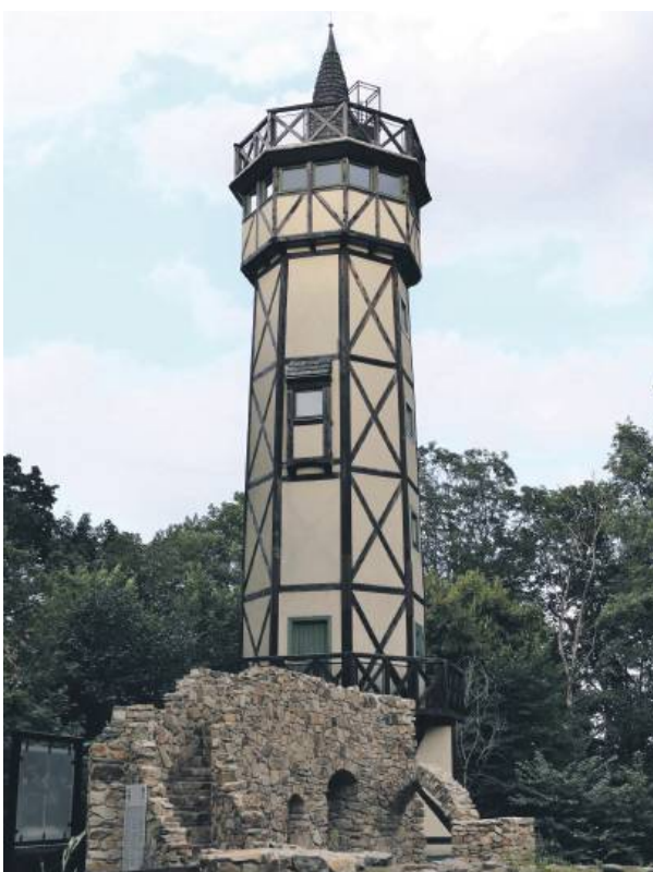
Wieża otwarta będzie w każdą sobotę i niedzielę
