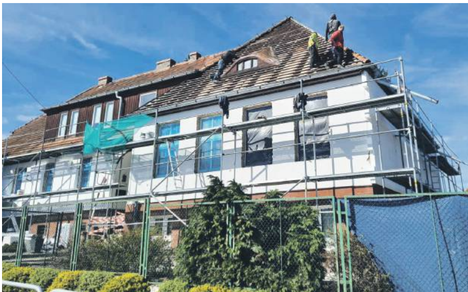
Rozpoczęły się już prace związane z termomodernizacją budynku szkoły w Żelowicach. Fot. UG Kondratowice
