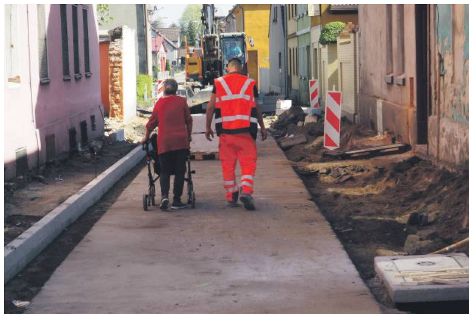
Ruszył remont ul. Sikorskiego i 1 Maja w Wiązowie. W trakcie prac przebudowana zostanie sieć kanalizacji deszczowej
