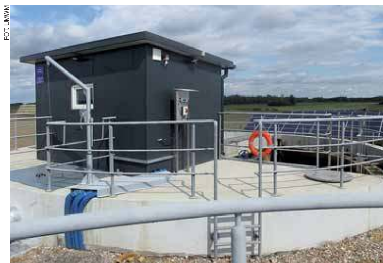
Gmina Zawidz - Przebudowa i rozbudowa gminnej oczyszczalni ścieków, remont pompowni ścieków stanowiących wyposażenie gminnej sieci kanalizacyjnej w Zawidzu Kościelnym i budowa sieci wodociągowej w Zawidzu Małym
