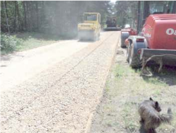
Utwardzenie półkilometrowego odcinka drogi kosztowało, jak podaje urząd, około 81 tys. zł
