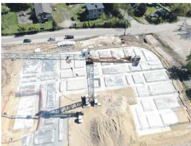
Trwają prace ziemne na terenie budowy
