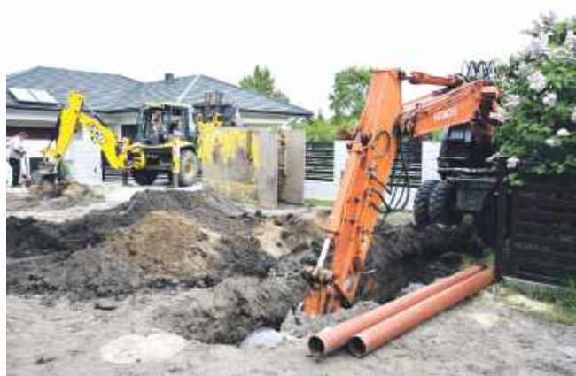
Budowa kanalizacji sanitarnej w Psarach
