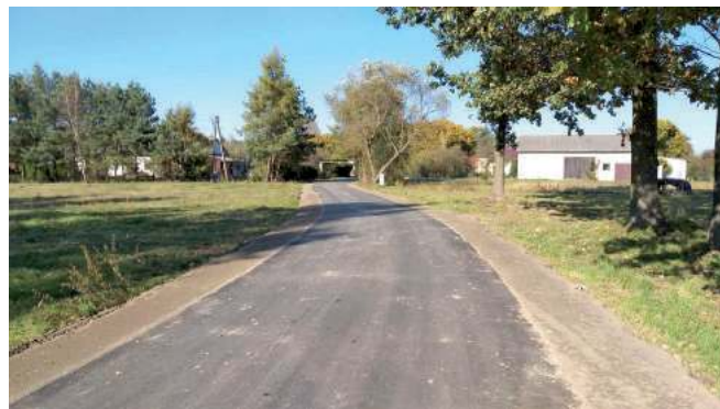
Przebudowę drogi w Bobowiskach za 133,9 tys. zł wykonał Zakład Budowy Wodociągów i Kanalizacji z Gór
