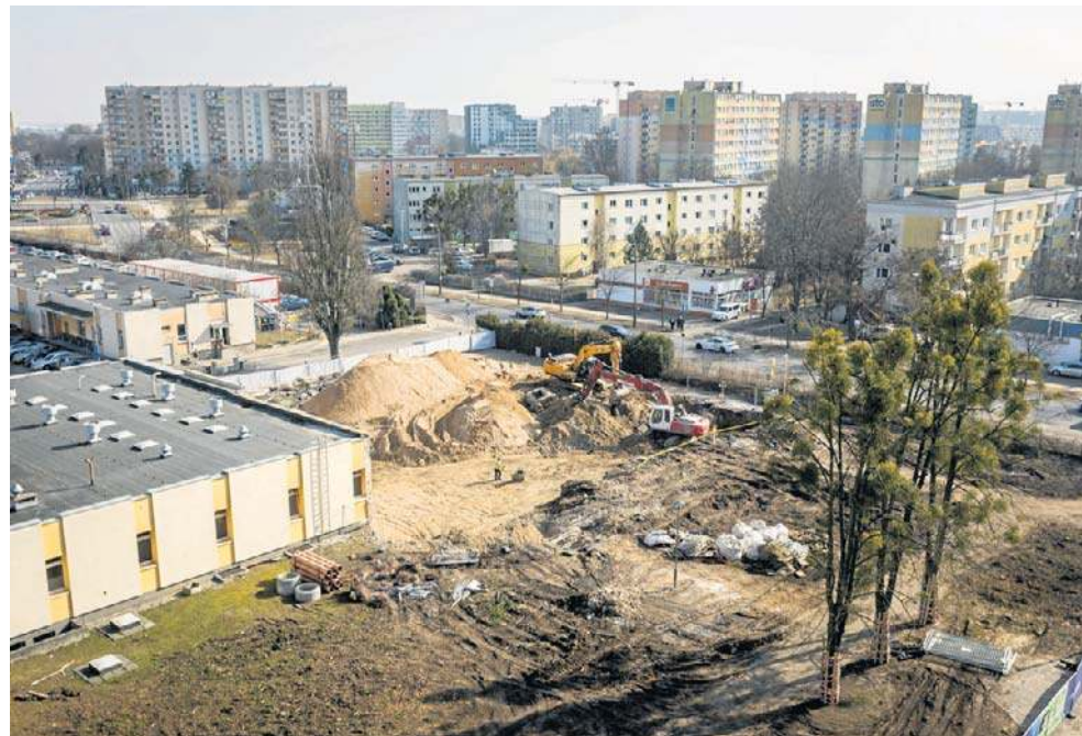
Jutro uruchomiony zostanie nowy wjazd i wyjazd na teren szpitala Jurasza od strony Alei Wyszyńskiego, który stanie się głównym dojazdem na czas prowadzenia inwestycji
