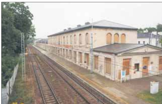
Dworzec kolejowy w Maczkach
