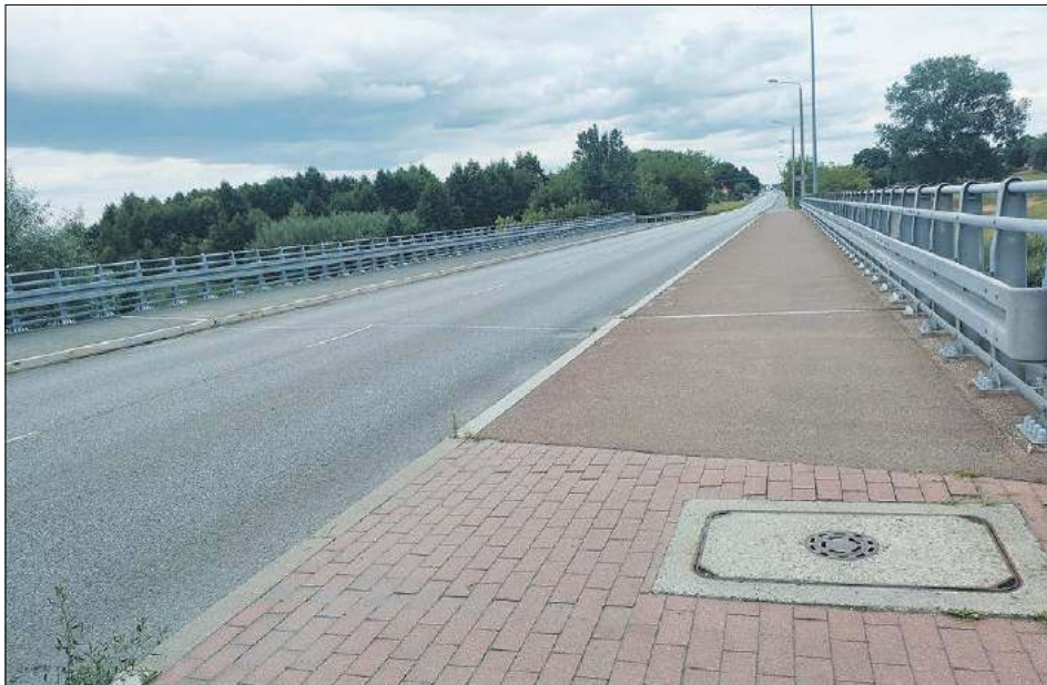
Na potrzeby przyszłej obwodnicy wzmocniona zostanie nawierzchnia Al. Solidarności i konstrukcja mostu
