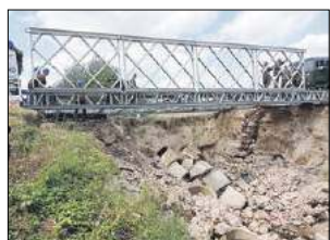
Most zamontowali saperzy z 1 Dęblińskiego Batalionu Drogowo-Mostowego
