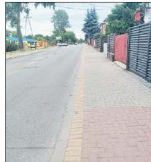
Miasto Biała Podlaska pozyskało dofinansowanie na remont ulicy Orzechowej na odcinku od Al. Jana Pawła II do ul. Leszczynowej
