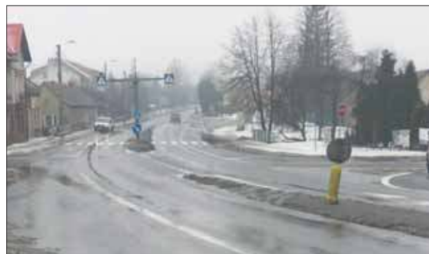
Budowa estakady, która ma zastąpić krajówkę, już niebawem doczeka się realizacji
