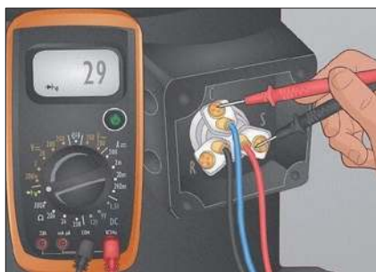
Rys. 2. Pomiar rezystancji uzwojeń sprężarki Źródło: wikohow.com
