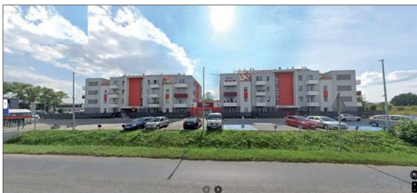
Fot. 1. Widok budynków przy ulicy Sowiogórskiej w Dzierżoniowie po zakończeniu inwestycji.
