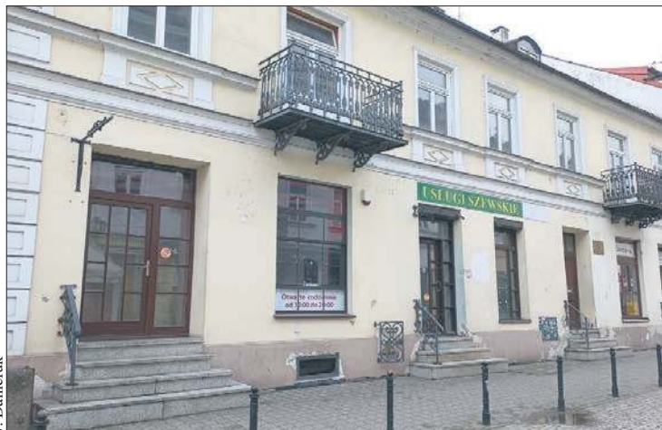
Rozpoczyna się przebudowa kamienicy przy ul. Grodzkiej 8
