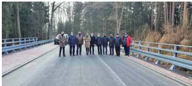
Przebudowa odcinka drogi i budowa mostu w Obrycie to jedna z ważniejszych inwestycji; tu odbiór drogi
