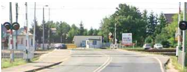
Prace rozpoczną się 7 września i potrwać około miesiąca
