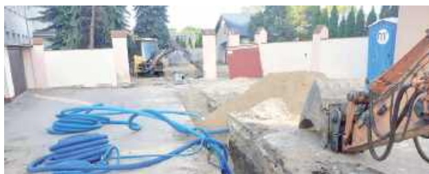
Roboty budowlane dotyczące projektu: „Wodę z nieba w raj na ziemi”
