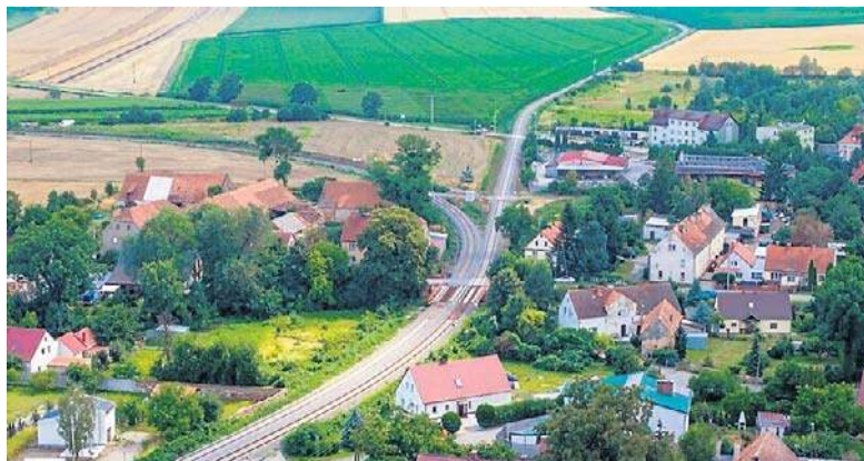
Linia kolejowa 310 w rejonie Kobierzyc i Jordanowa Śląskiego.
