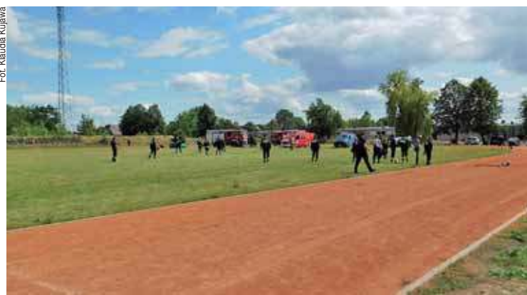
Podczas modernizacji stadionu w Siemiatkowie naruszono pięć artykułów ustawy o zamówieniach publicznych
