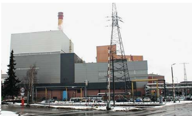
Energa Kogeneracja jest odpowiedzialna w Elblągu za produkcję 80 proc. ciepła płynącego do odbiorców
