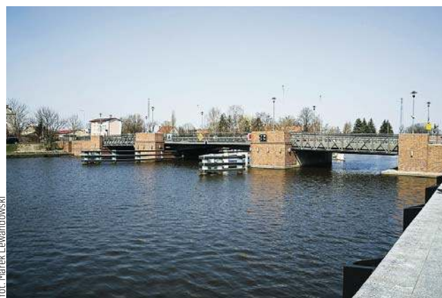
Mosty zwodzone oddano do użytkowania w 2013 roku. Niestety ich stan techniczny od początku stwarzał problemy
