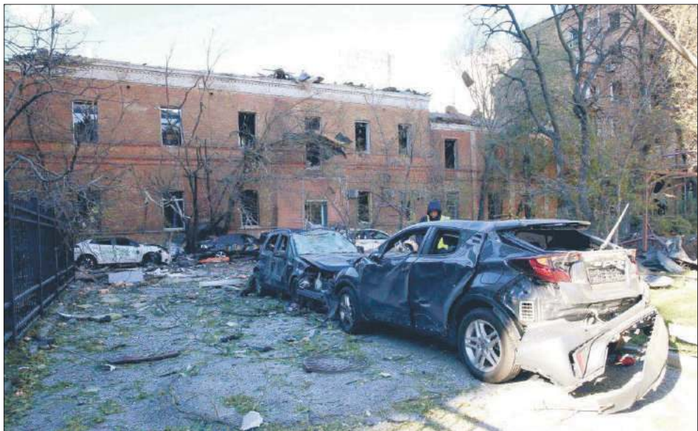
Krajobraz po ataku rakietowym: zniszczone domy, infrastruktura, samochody.
