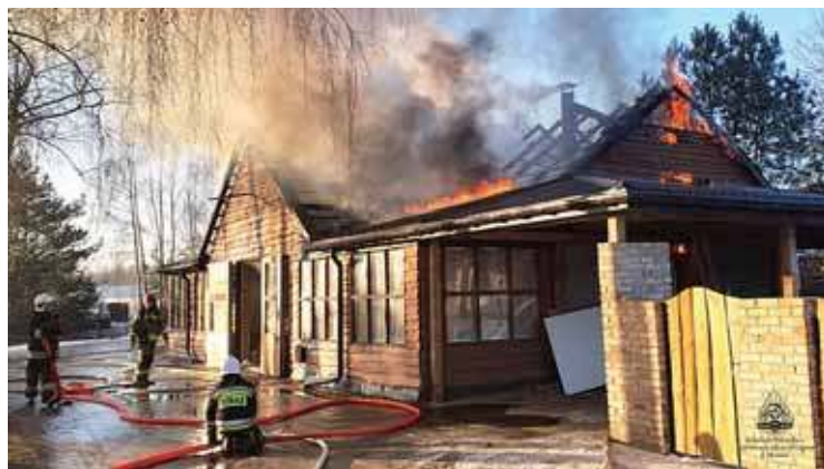
Ogień błyskawicznie opanował cały obiekt
