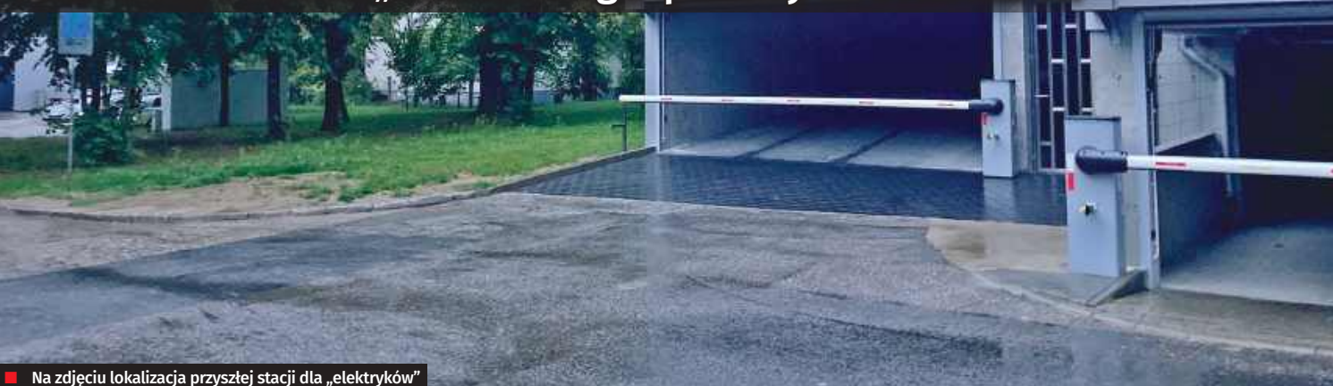
Na zdjęciu lokalizacja przyszłej stacji dla „elektryków”
