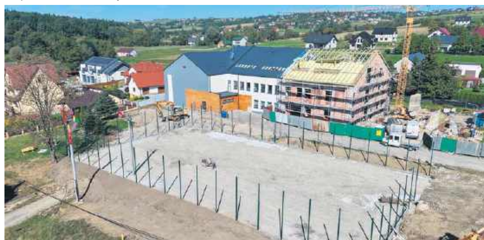
Rozbudowa szkoły i budowa boiska w Łęce
