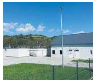
Stacja uzdatniania wody
