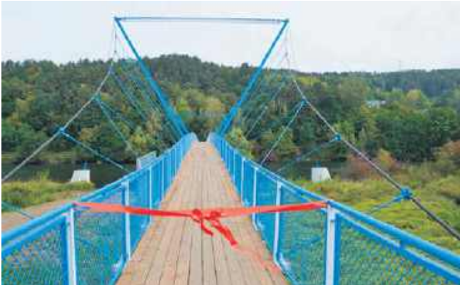
Kładka wisząca pieszo-rowerowa Witowice Dolne- Tropie
