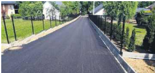
Droga Łososina Dolna-Jarostowa
