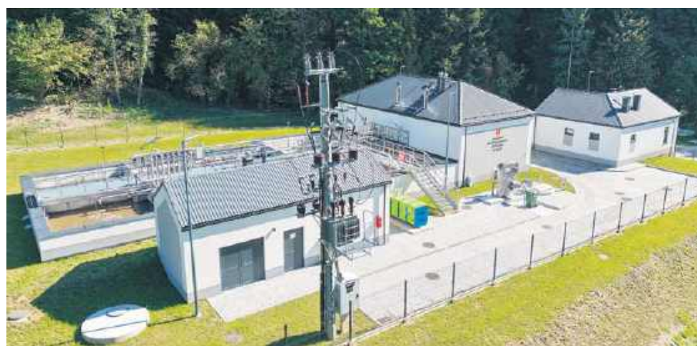
Oczyszczalnia ścieków w Łęce
