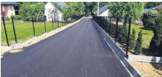
Droga Łososina Dolna-Jarostowa
