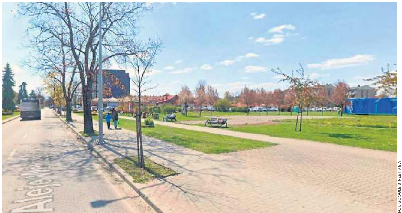
Stara Sandecja od nowego roku zamieni się w tymczasowe targowisko, gdzie przeniosą się kupcy na czas remontu Rynku Maślanego. Potem duży plac może całkowicie zmienić swoje przeznaczenie i rozwiązać problem parkingów
