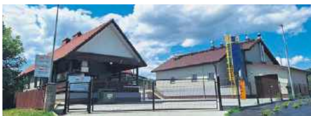
Oczyszczalnia w Tęgorz
