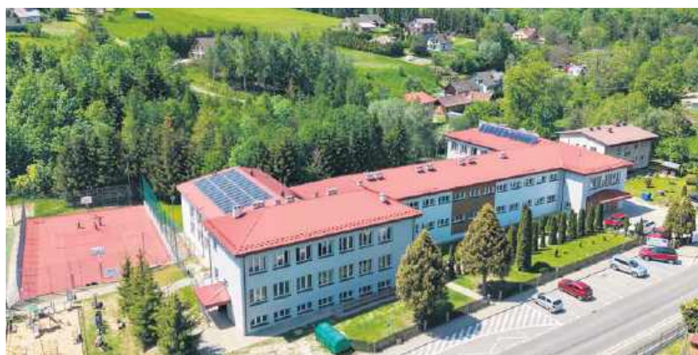
Lipnica Wielka - szkoła po termomodernizacji 2026 i zmodernizowany ORLIK 2025
