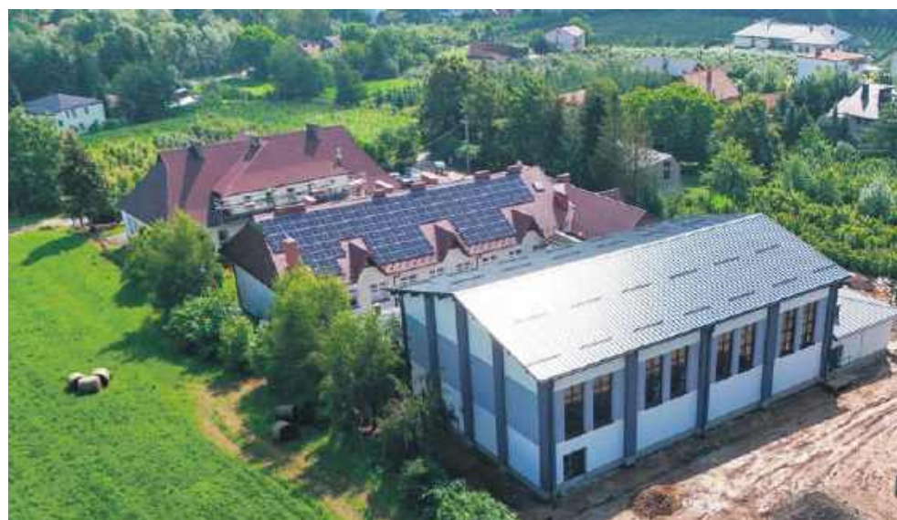
Budowa sali gimnastycznej w Czarnym Potoku
