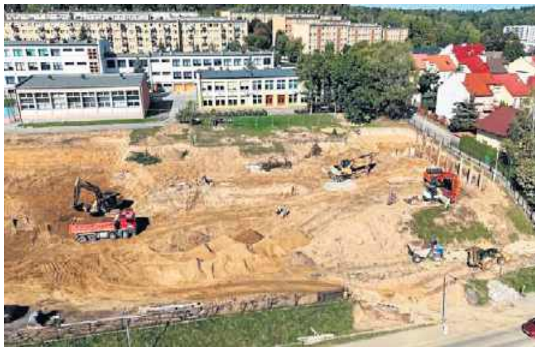
Budowa pierwszego takiego obiektu w Małopolsce trwa
