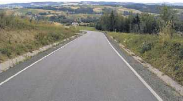
W każdej miejscowości modernizowano drogi gminne. Droga Kwiatonowice – Bugaj.
