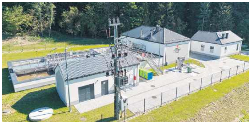
Oczyszczalnia ścieków w Łęce
