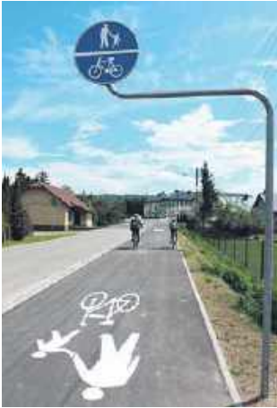
Wybudowano wiele odcinków ścieżek pieszo-rowerowych. Powstają kolejne.
