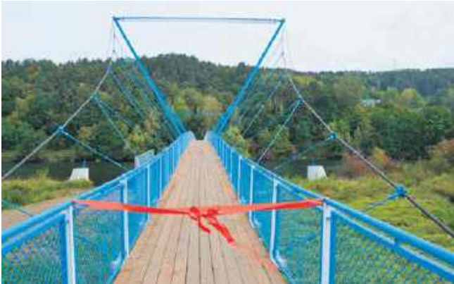
Kładka wisząca pieszo-rowerowa Witowice Dolne- Tropie
