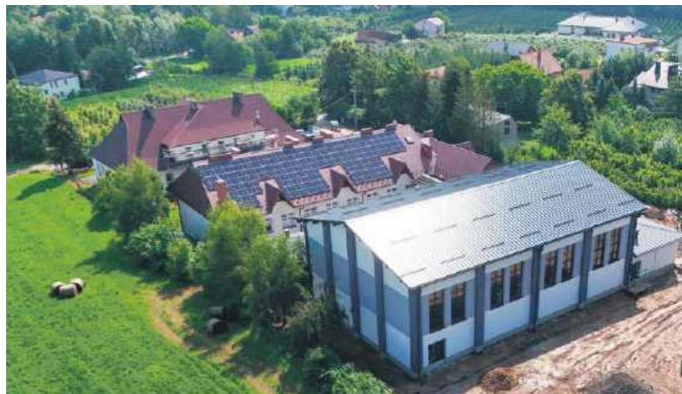
Budowa sali gimnastycznej w Czarnym Potoku
