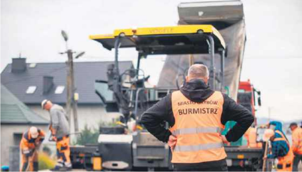
Budowa dróg na terenie Miasta Grybów FOT. MATEUSZ KSIĄŻKIEWICZ
