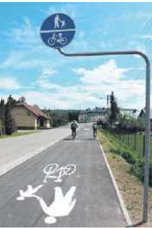
Wybudowano wiele odcinków ścieżek pieszo-rowerowych. Powstają kolejne.
