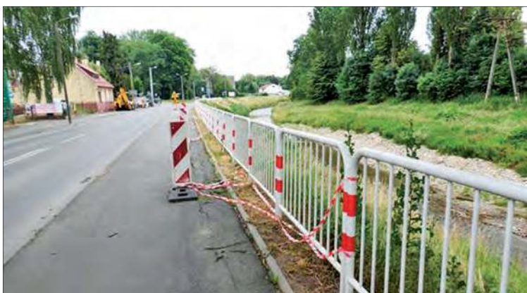
W ramach zadania zaplanowano: rozbiórkę zniszczonej nawierzchni i podbudowy; remont nasypu ścieżki; wykonanie nowej podbudowy i nawierzchni; montaż elementów betonowych; ustawienie barier zabezpieczających; wykonanie oznakowania poziomego.
