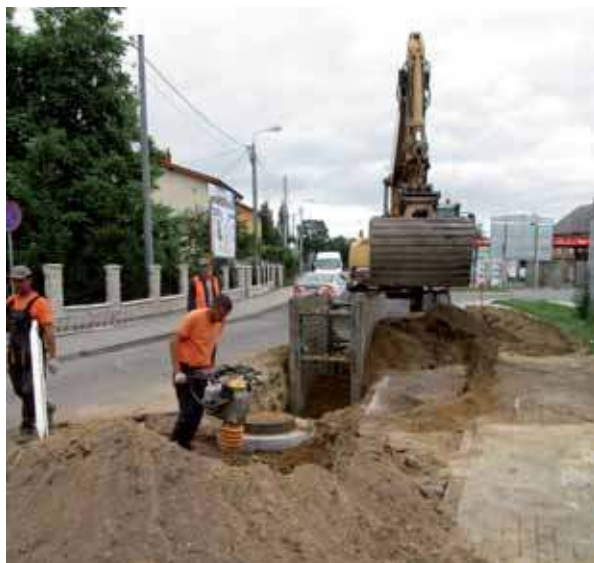
Prace na ul. Kościelnej
