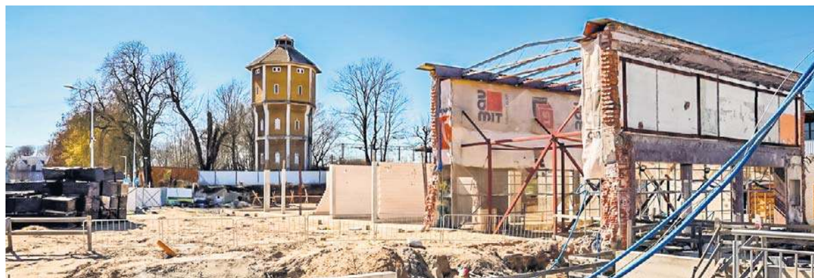
Pozostałości po byłym budynku dworca - stan obecny
