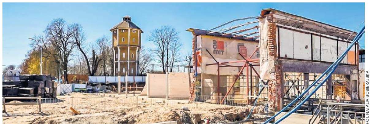
Pozostałości po byłym budynku dworca - stan obecny
