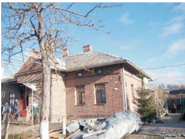
Polscy dekarze uporali się z dachem plebanii w ciągu 5 dni
