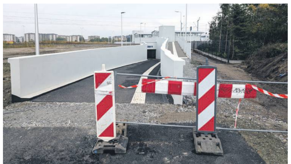
Dziś to miejsce jest zabezpieczone - przed wypadkiem zabezpieczenia nie było
