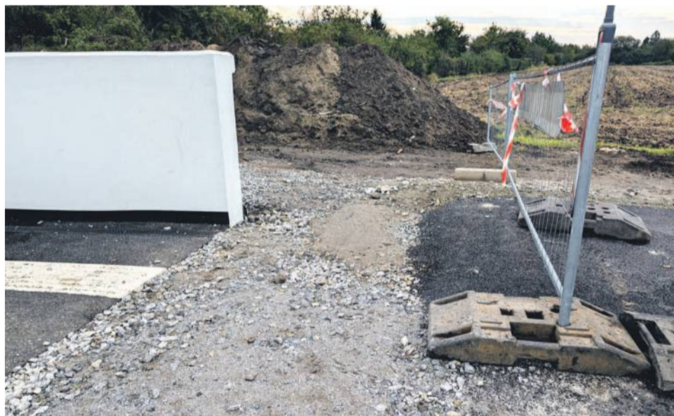
Tu chłopak mógł stracić panowanie nad pojazdem. Łagodne przejechanie tego miejsca - asfalt nagle się kończy i nie ma połączenia z nawierzchnią drogi w tunelu - dla hulajnogi jest niemal niemożliwe. Musiała podskoczyć, a przednie koło z łatwością mogło uciec i odmówić posłuszeństwa.
