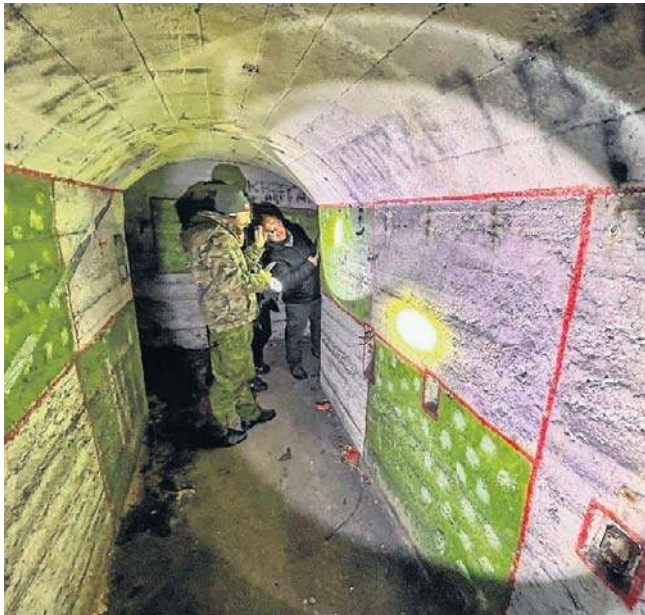
Szczeliny przeciwlotnicze w Legnicy są w różnym stanie
