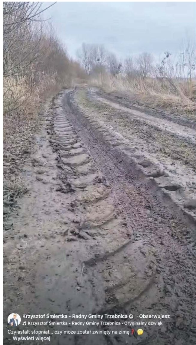
Tak wygląda połączenie Małuszyna z drogą powiatową
