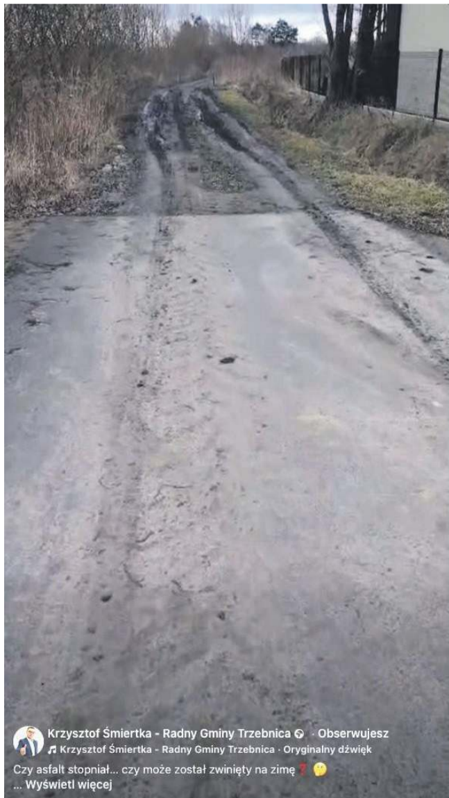
Na filmie widać, gdzie kończy się asfalt
