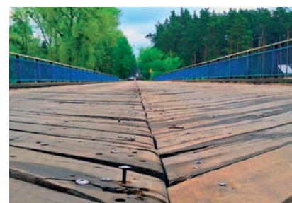
Powiat przygotowuje się do budowy nowego mostu
